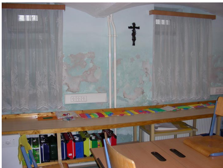
In diesem Zustand präsentiert sich der Multifunktionsraum im Kellergeschoss der Volksschule, wo unsere Schulkinder unter anderem ihren Werkunterricht erhalten sollen
