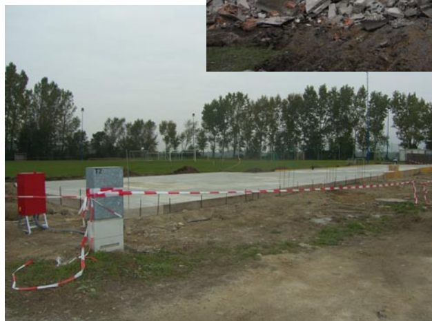
Die Bodenplatte sowie die Kanalverrohrung sind Mitte Oktober fertig
