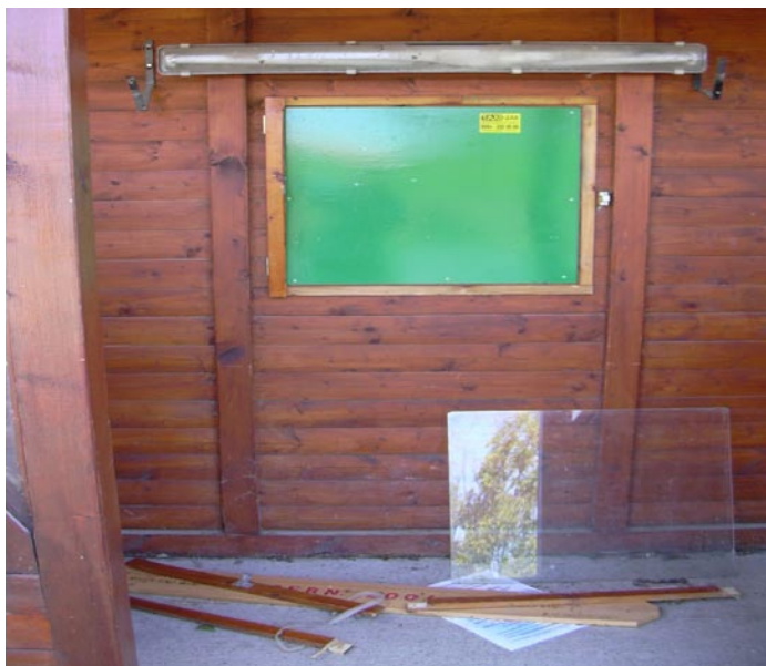
Das Buswartehäuschen bei der Volksschule
