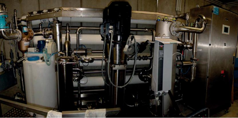
Als Verfahren zur Wasseraufbereitung, vornehmlich zur Entfernung der beiden Parameter Desethylatrazin und Nitrat, wurde das Membranverfahren (Nanofiltration / Umkehrosmose) gewählt. Technisch betrachtet handelt es sich um ein druckbetriebenes Membrantrennverfahren, welches zwecks Optimierung des Rückhaltes von Schadstoffen als kombiniertes Verfahren Nanofiltration (NF) / Umkehrosmose (UO) ausgeführt wurde.
